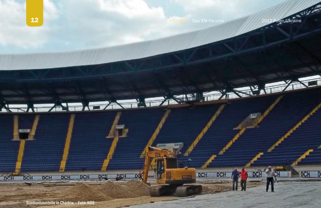
Stadionbaustelle in Charkiv – Foto: KOS
